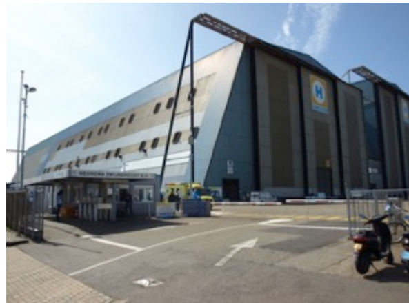
Veel ruimte op daken beschikbaar voor zonnepanelen
